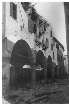
Casa ai n. 8/8a di via Savonarola, angolo via Montona, 4-5 febbraio 1918
